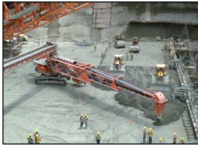
Figura 9- Utilización del Crawler y de la grúa Potain MD-1100
