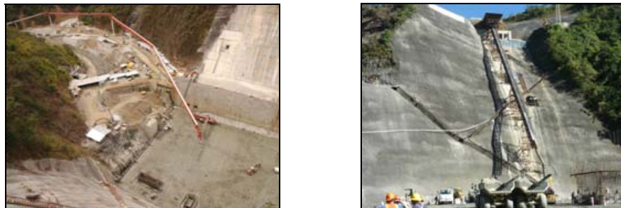
Figura 8- Transporte y descarga del RCC con banda y con canoa/vagoneta
